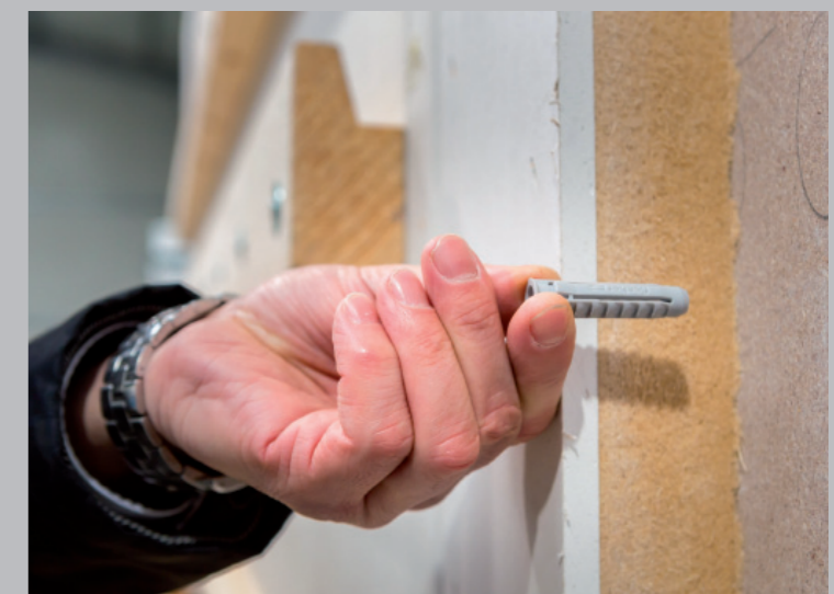
Für das Experiment werden normale, handelsübliche Dübel verwendet. Diese dringen nur in die etwa 6 cm dicke Installations-ebene (Gipskarton- und Holzfaserdämmplatte) ein. Die Wandkonstruktion unterscheidet sich nicht vom üblichen Aufbau.
