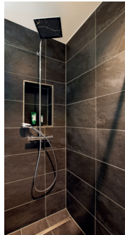
Das Duschbad im Erdgeschoss: Armatur und Fliesen – alles schon inklusive.
