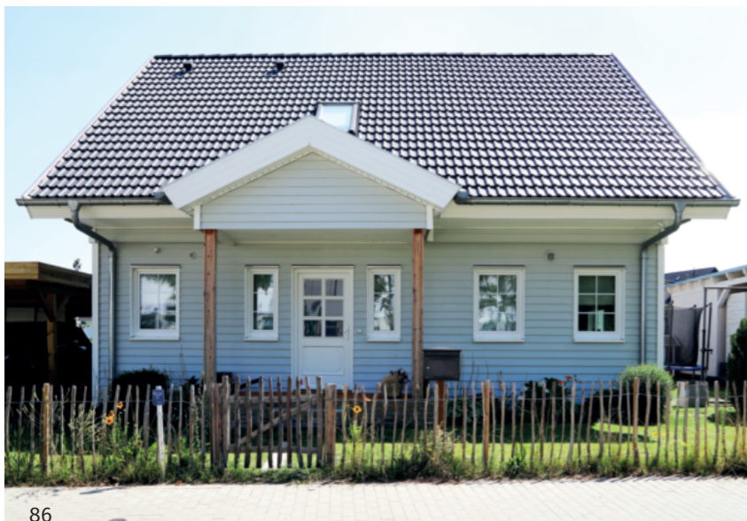
Die Hauseingangsüberdachung wird von zwei naturbelassenen Holzbalken getragen.
